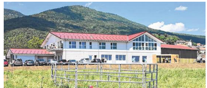
Au rez, la fromagerie et le magasin, à l'étage, salles et espace didactique. A gauche, l'entrée pour les camions du lait.
